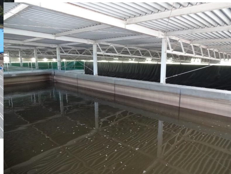
浸出水調整槽の被覆
